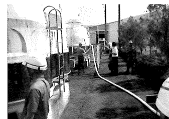
③可搬ポンプを使用して冷却塔内に水を補給
